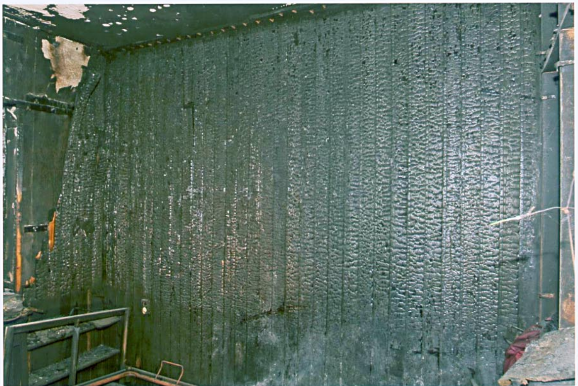
▲ Lichtbild 4 Mit Nut- und Federbrettern verkleidete Außenwand im Krankenzimmer
