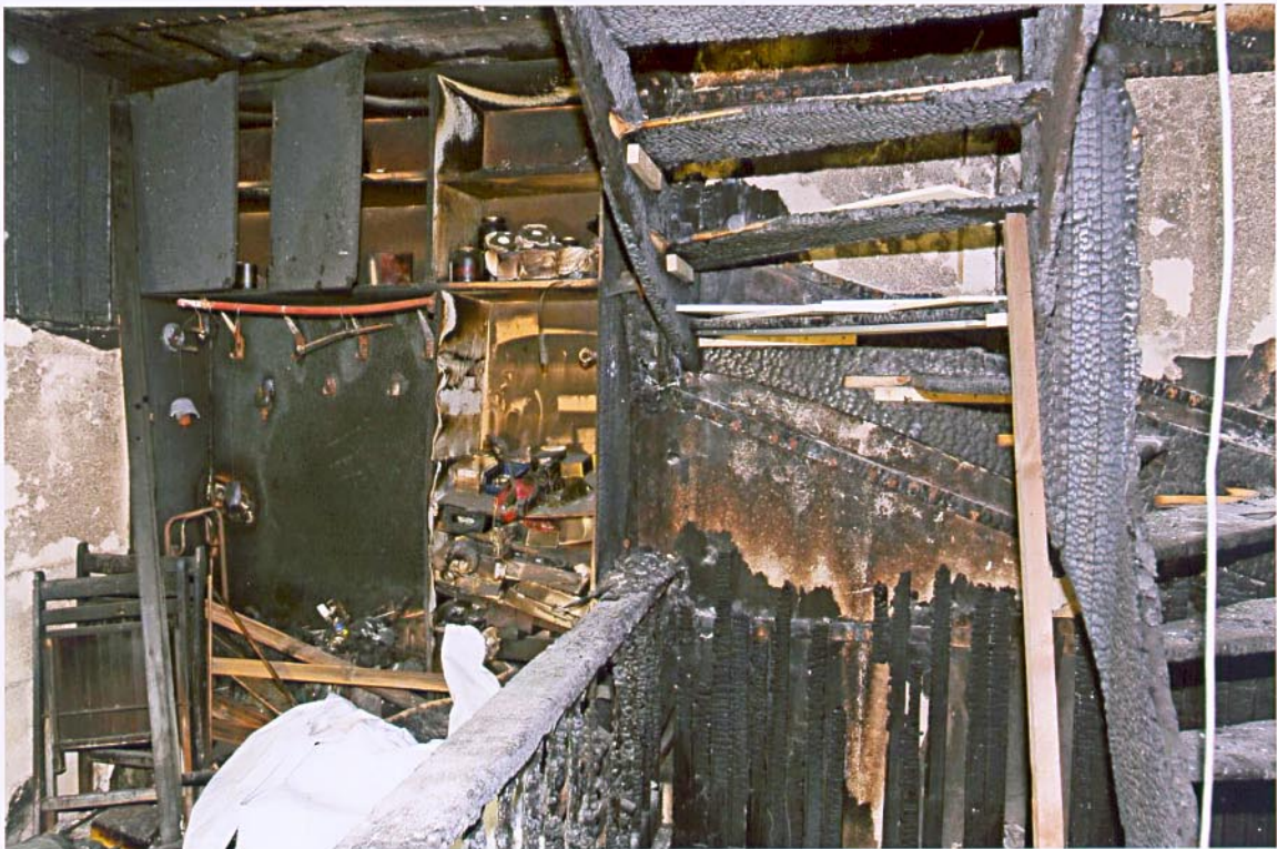
▲ Lichtbild 41 Treppenhaus und Garderobenschrank im Erdgeschoss
