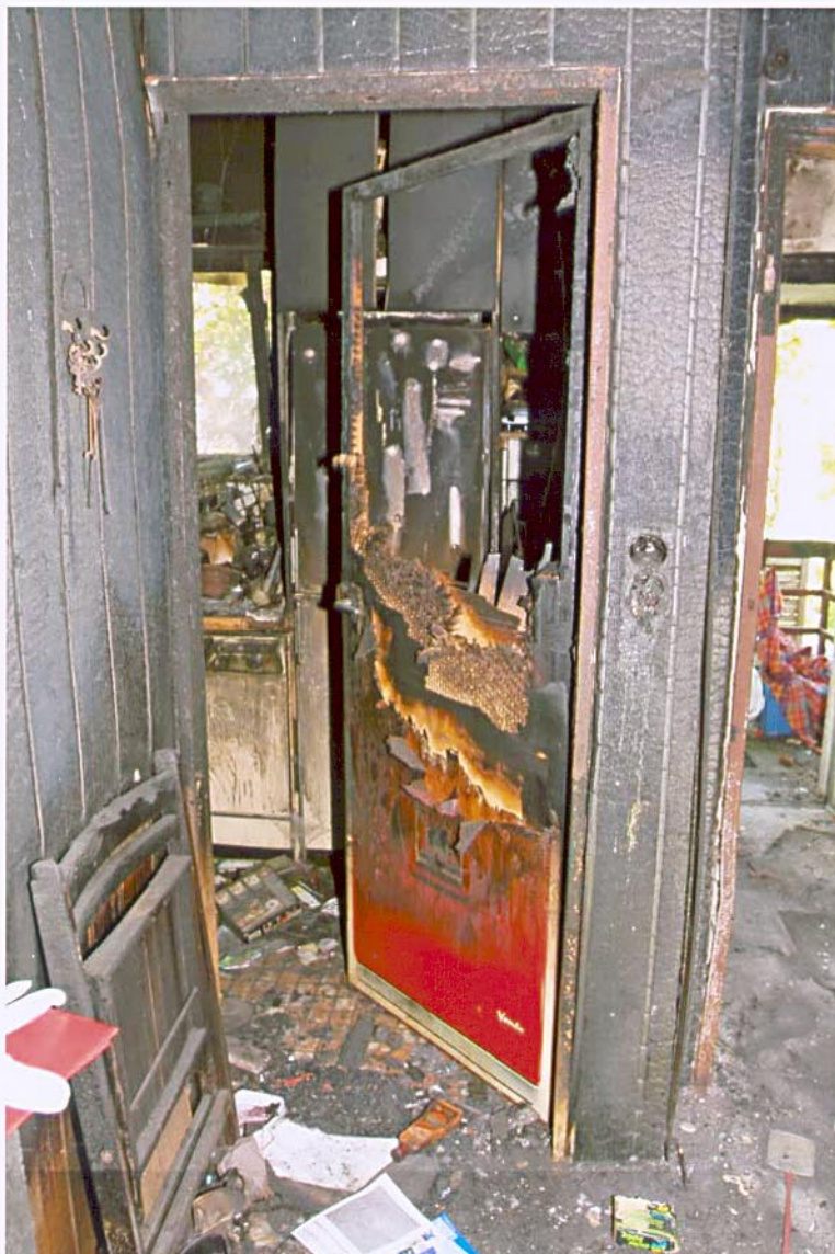
◀ Lichtbild 43 Küchentür im Erdgeschoss
